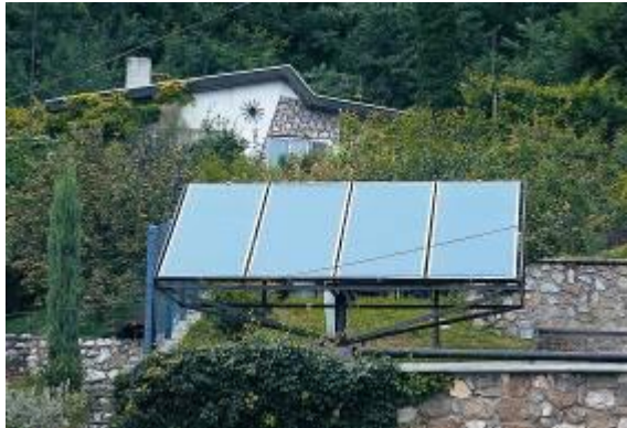
Upevnenie kolektorov pomocou nosnej konštrukcie.
