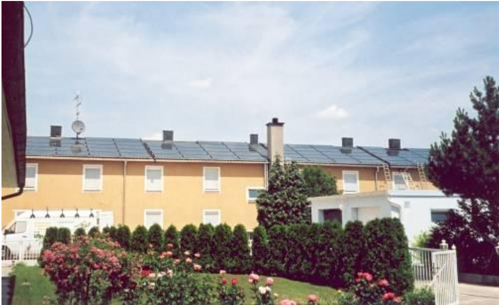
Solárna príprava teplej vody vo viacbytovom obytnom dome.
