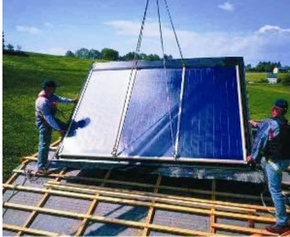
Montáž kolektorov pomocou žeriavu. Zdroj: Bramac.
