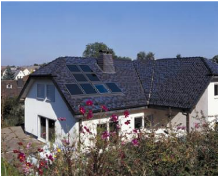
Kombinácia strešného okna a slnečných kolektorov na jednej streche.
